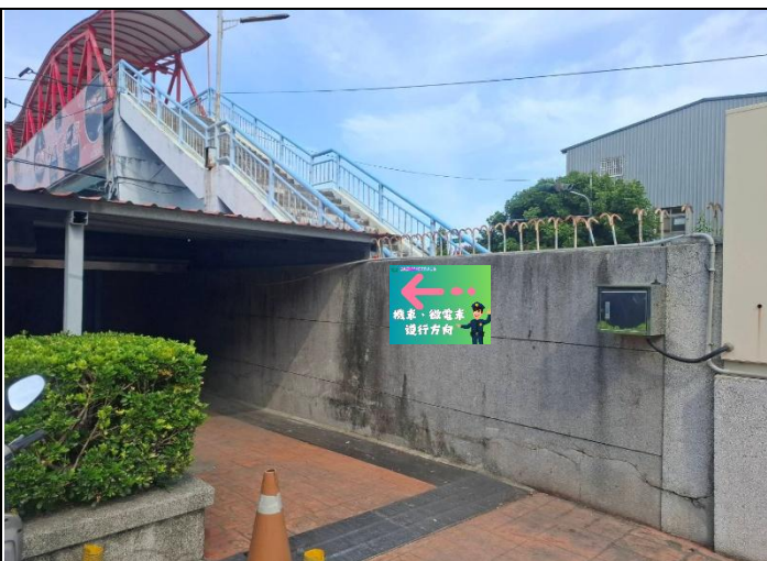
機車及微電車進出口
